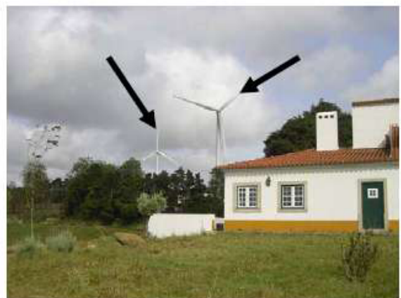
Bild 2. Ansicht vom Anwesen. Die beiden WKA sind ungefähr 322m und 642 m entfernt.
